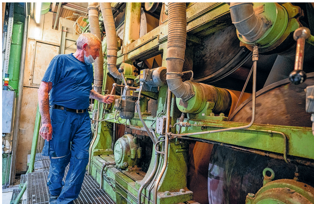
Pierre Warkus tjekker, om der er sket nogle aflejringer på maskinen. Foto: Martin Ziemer
